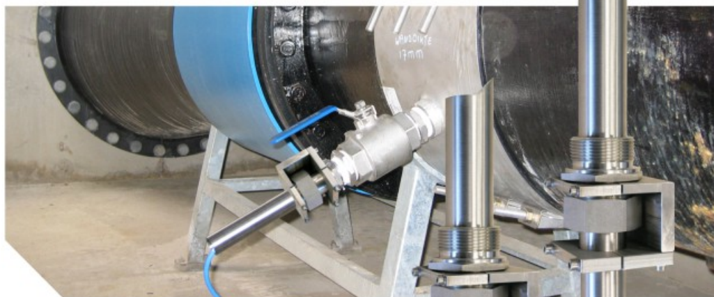
Sensores de velocidad para instalación en tubos como en el NPP (Tubo Perfil NIVUS)
