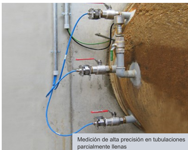
Alternativa a los caudalímetros eletromagnéticos. Instalación sin remover los equipamientos existentes.
