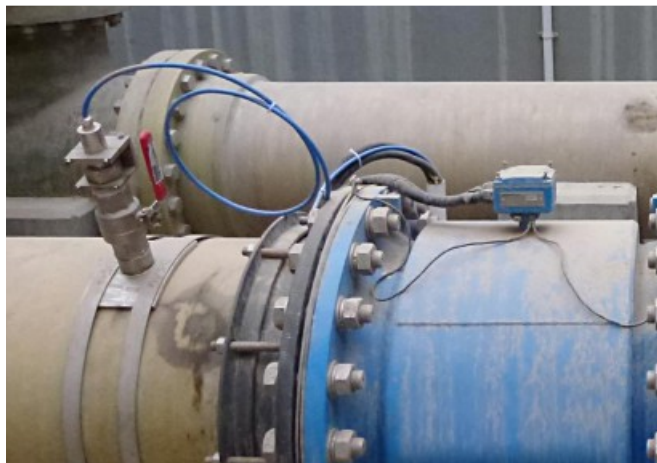
Alternativa a los caudalímetros eletromagnéticos. Instalación sin remover los equipamientos existentes.
